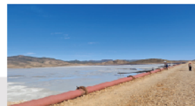
排水管道加固技术
