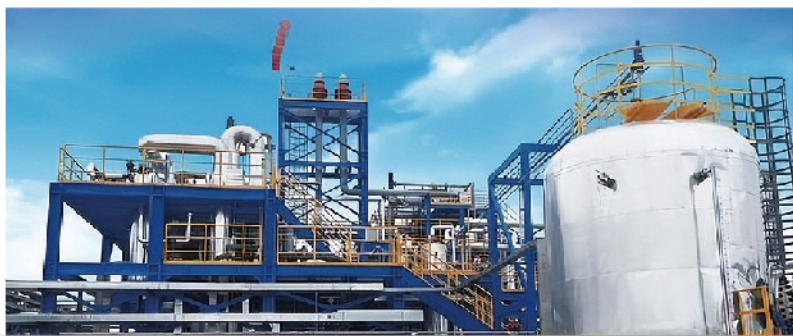
永宁金铅冶炼有限公司还原炉、烟化炉节能减排技术升级改造项目
