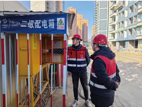
安全检查 Safety Inspection
